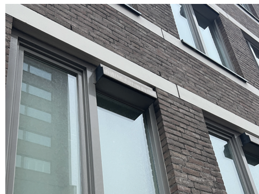
Voorbeeld van suskast in de ramen
