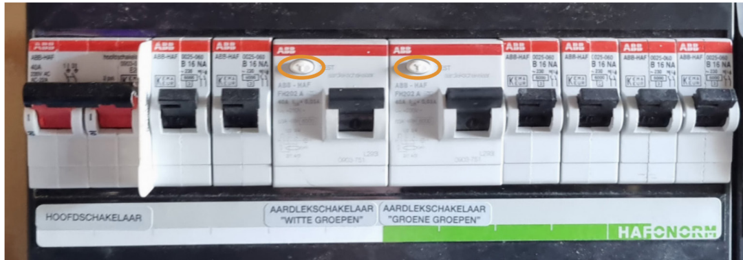
De locatie van de tekstknop 'T' in uw meterkast
