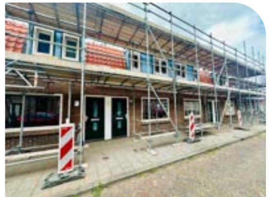
Voorbeeld van steigerwerk. De Ruyterstraat, IJmuiden. Aannemer: Hemubo
