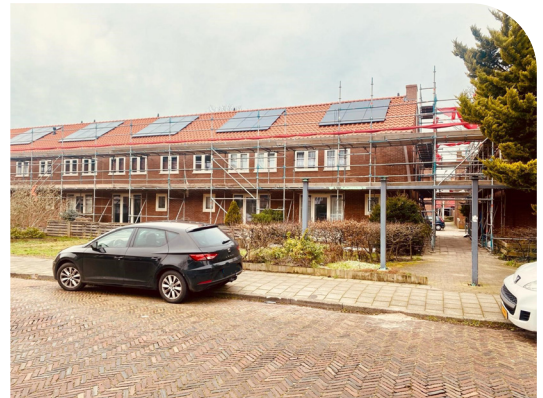
Voorbeeld van steigerwerk. Heuvelwijk, IJmuiden. Aannemer: Coen Hagedoorn
