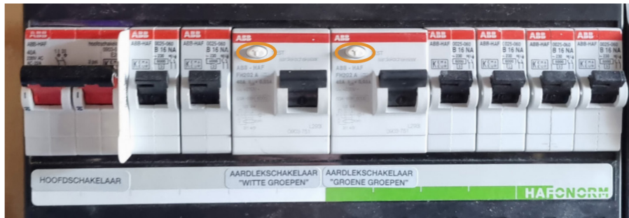
De locatie van de testknop 'T' in uw meterkast
